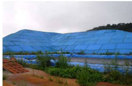
仮設シートによる養生
