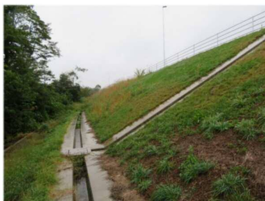
盛土斜面の整備状況の例
