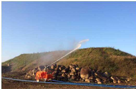
盛土への散水
