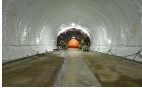
昆布トンネル(桂台)他 FILM施工状況
