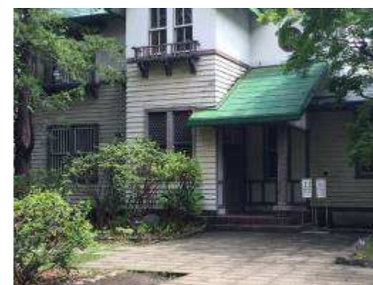
正面のエントランス部分ではバリアフリーの解決は困難
