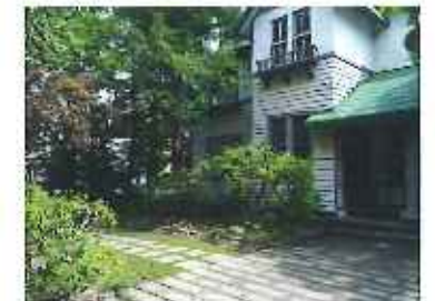
玄関廻りの雑然とした植樹帯も整理が必要の外観
