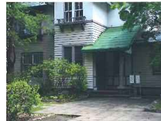
正面のエントランス部分ではバリアフリーの解決は困難
