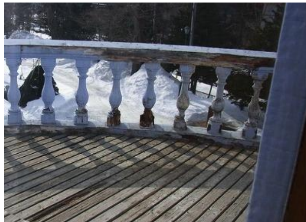
＜写真：2 階バルコニーの状況＞
