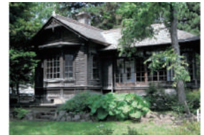
耐震化工事の対象施設のひとつである清華亭
