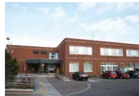
地域住民がレクリエーションなどに利用する地区センターの一角にある。
