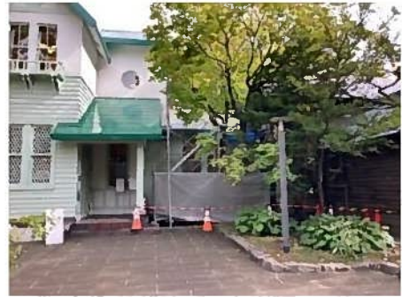
▲ 9/17 旧三菱鉱業寮屋根修繕作業の様子
