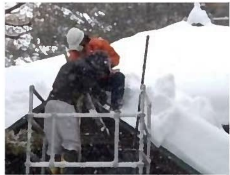
▲ 2/9 旧永山邸棟飾り撤去作業の様子
