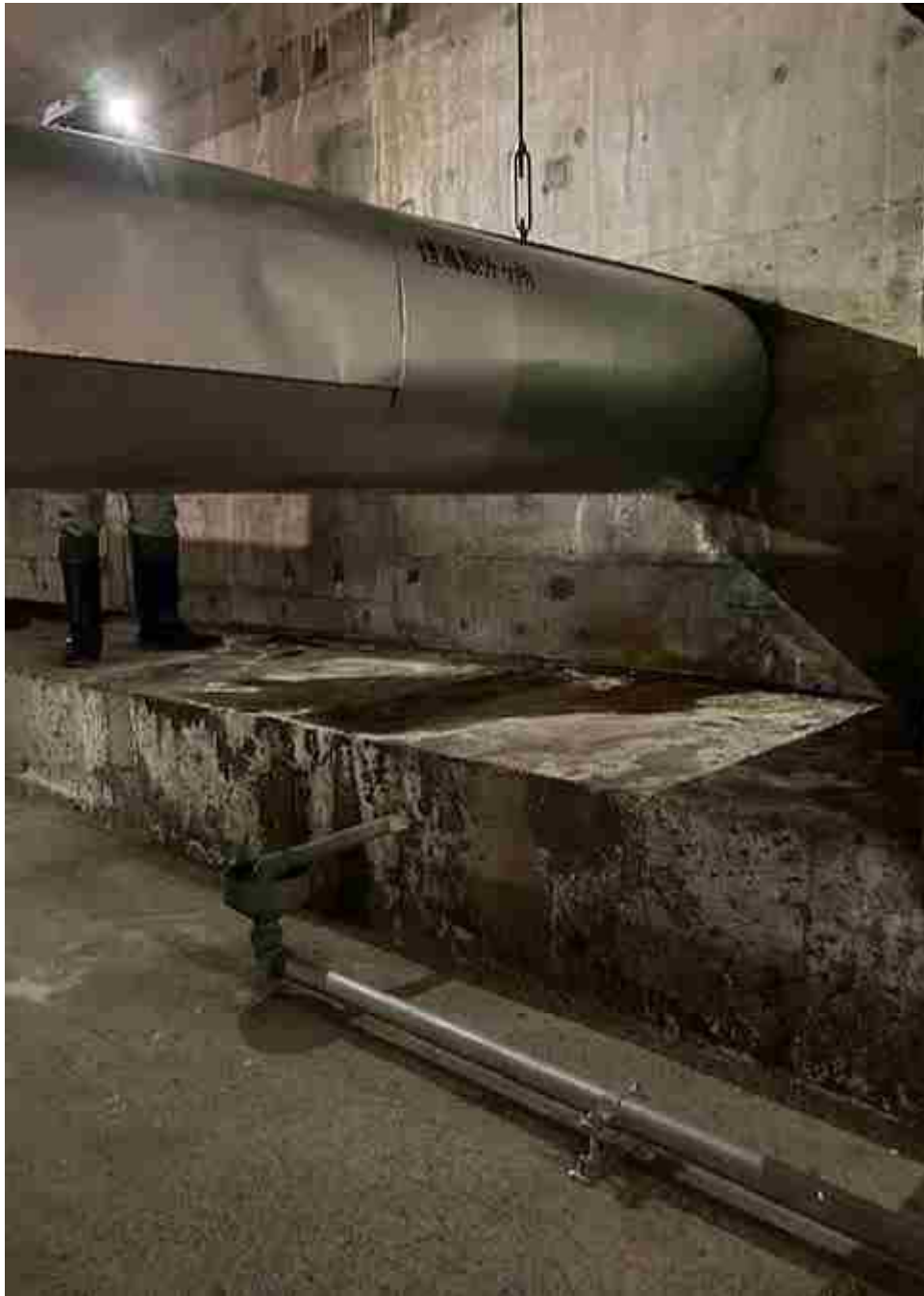
市民ギャラリー地下ピット内 横煙道
