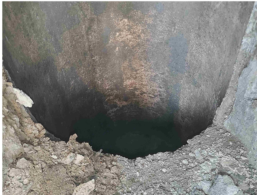
煙突外部点検口から煙道下方見下げ
