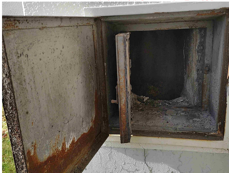
煙突外部点検口（二重扉を開放した状態）
