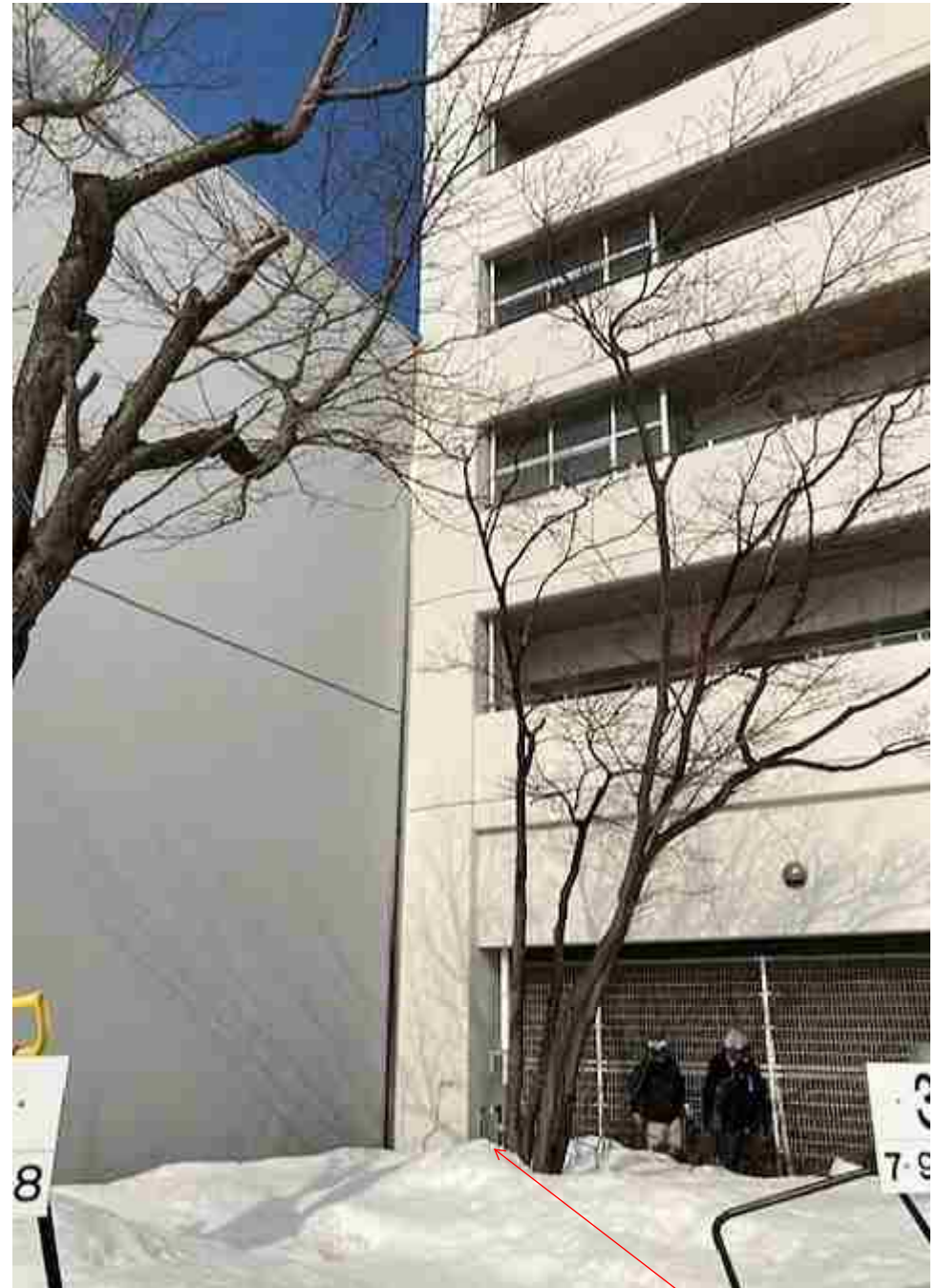
煙突外部点検口
