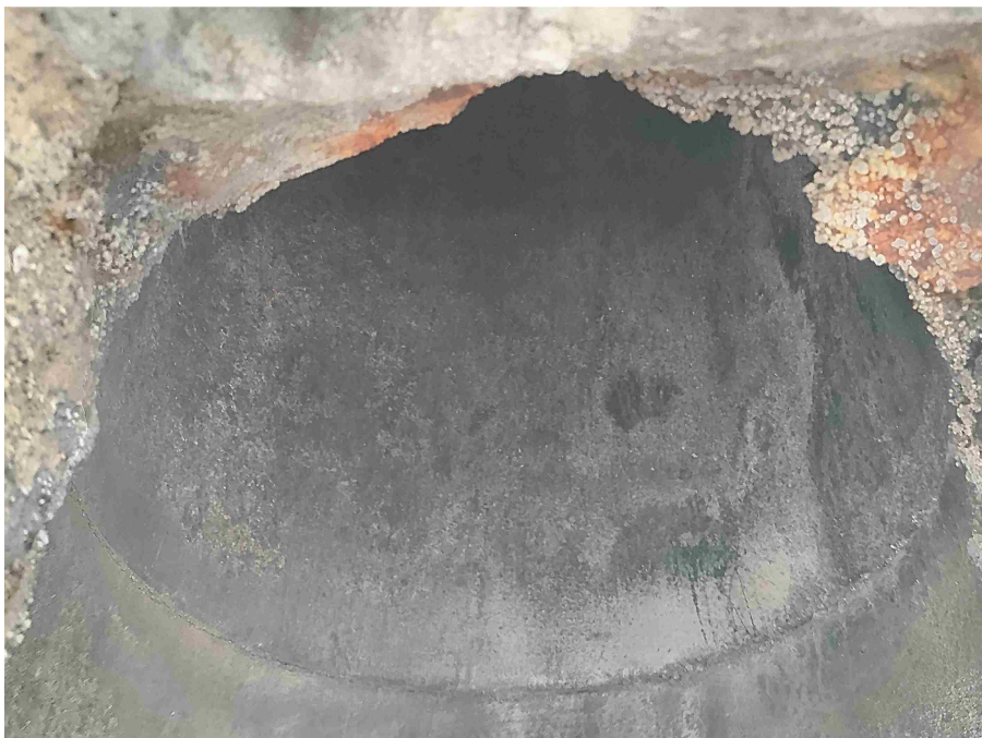
煙突外部点検口から煙道上方見上げ
