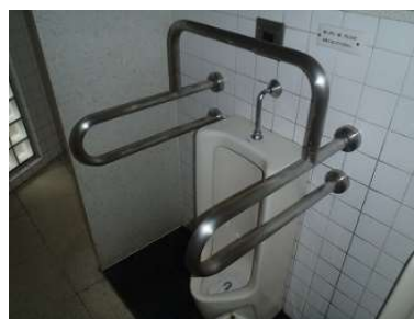
【小便器の手摺取り付け】
