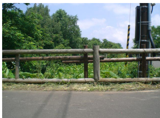
左写真の修繕後状況
