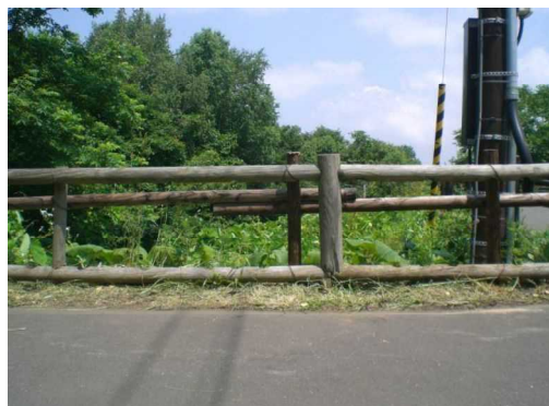
左写真の修繕後状況
