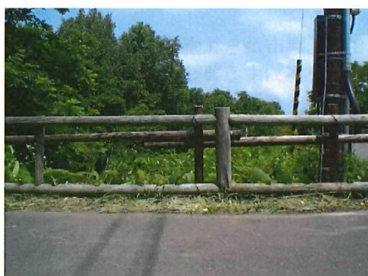
左写真の修繕後状況
