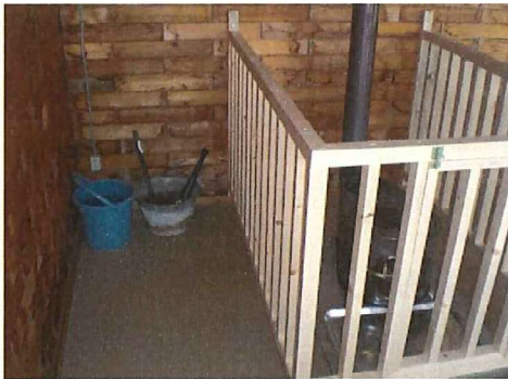
休憩スペースの薪ストーブ
