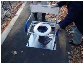
災害用マンホールトイレ
