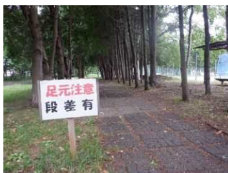
園路の修繕箇所
