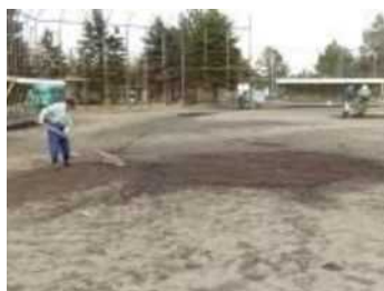
守備定位置、バッターボックスなど不陸ができやすい箇所はこまめな補修
