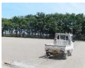
大規模な整地は機械を用いて効率的に作業
