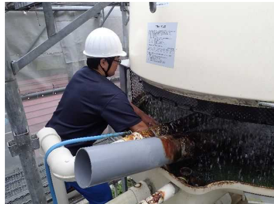
配水塔上部の清掃（苔類の除去）
