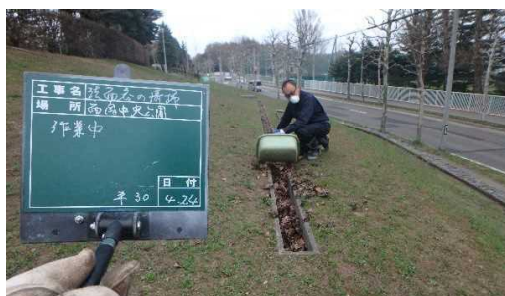
側溝清掃の様子
