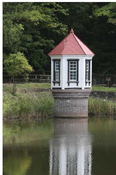
登録有形文化財「旧西岡水源池取水塔」
