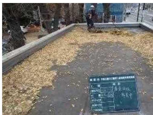
トイレ屋上 落葉清掃中
