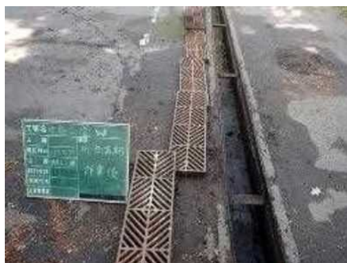
U型側溝清掃後
