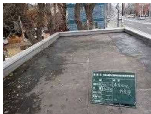
トイレ屋上 落葉清掃後
