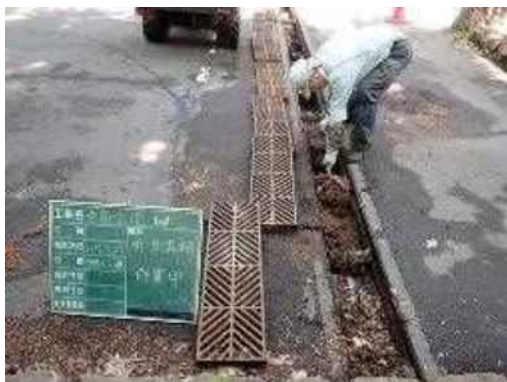
U型側溝清掃中
