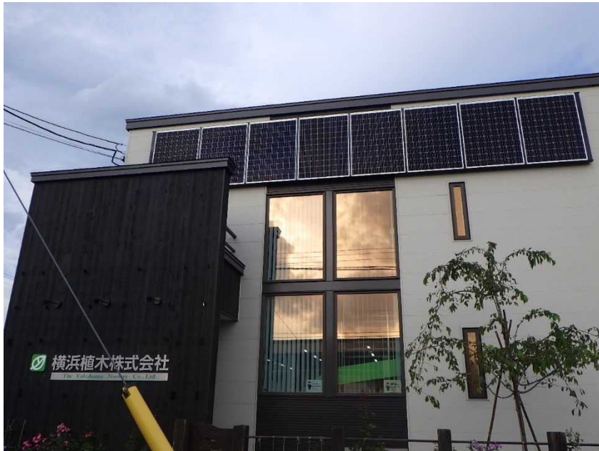
横浜植木株北海道支店太陽光発電パネル
