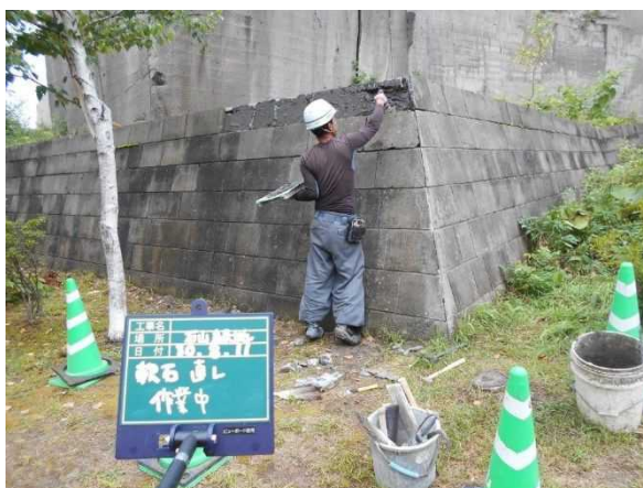
軟石の擁壁 修繕状況
