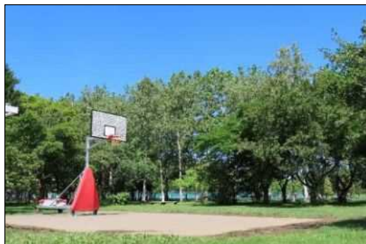
バスケットゴール設置状況
