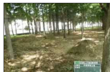
チップの敷き均し
