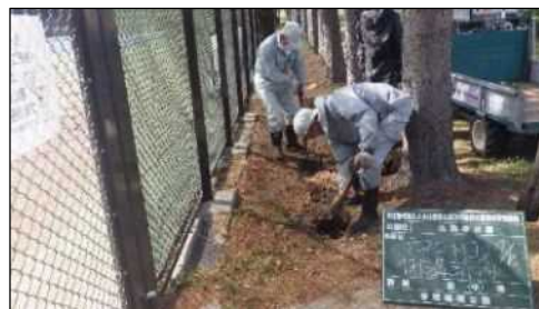
北発寒公園 U型側溝清掃
