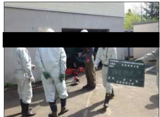
作業機械点検実施状況
