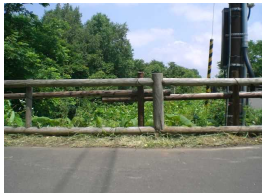
左写真の修繕後状況
