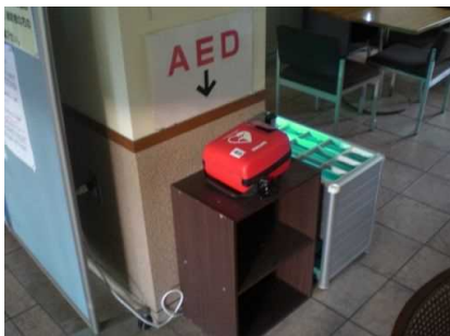
管理事務棟に設置 してあるAED
