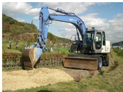
園内でのチップ敷均し状況
