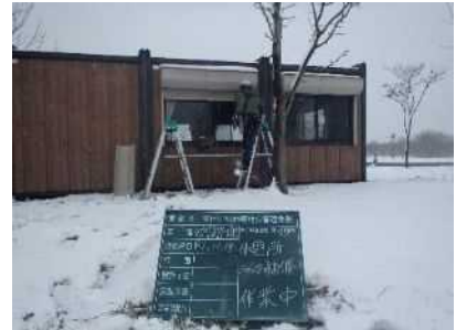
休憩所のシャッター補修
