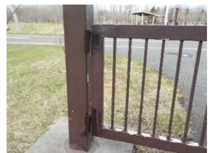
門扉(丁番)の補修
