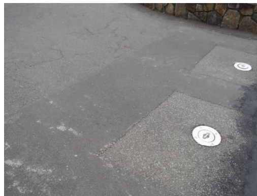
園路の修繕後
