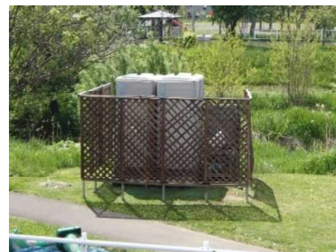
ラティスの設置
