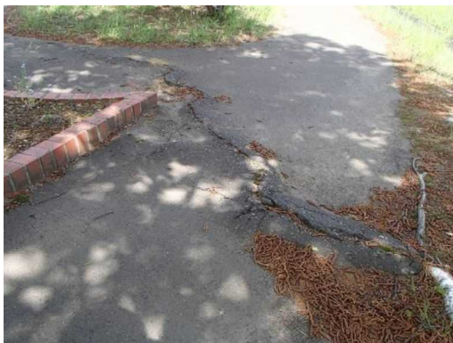
園路の修繕箇所
