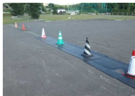
側溝補修中の安全措置
