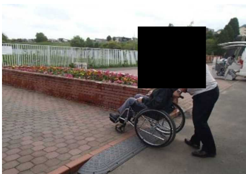
車イス利用者のための段差解消
