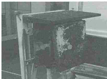
盤の腐食
