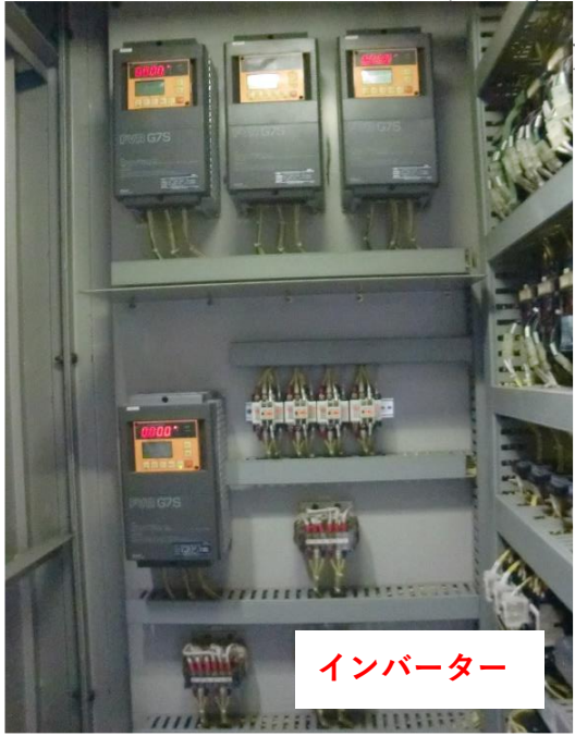
噴水動力制御盤
