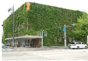
壁面緑化 (名古屋市) 建物の外壁面における緑化
