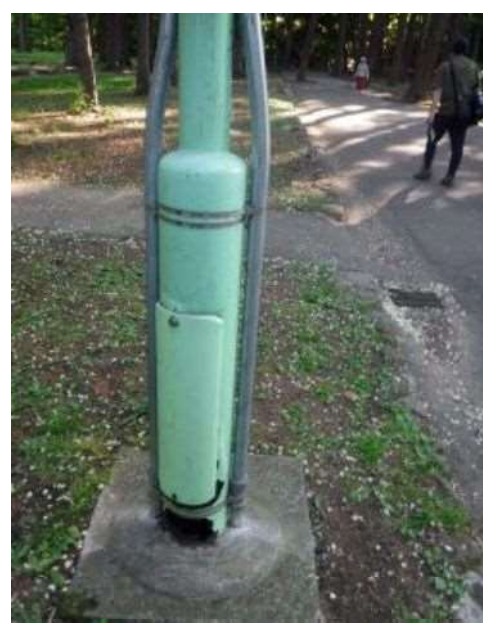
8 撤去・設置 ②
