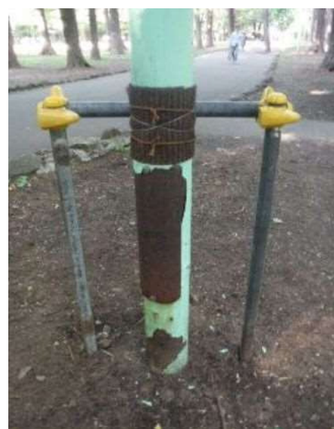
7 撤去・設置 ②
