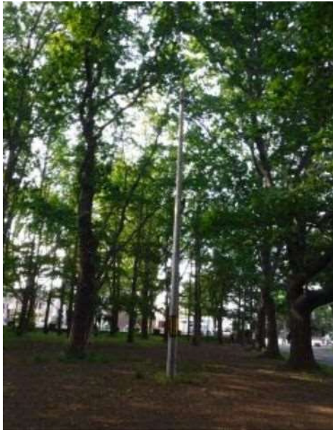
1 北電柱にLED共架設置
