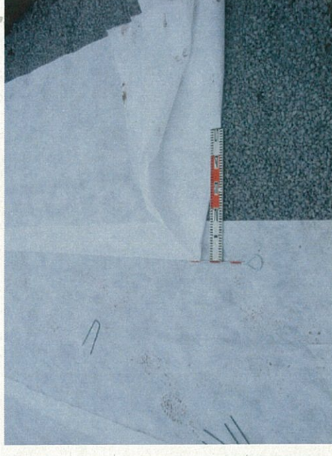
砕石の上に不織布を敷設
