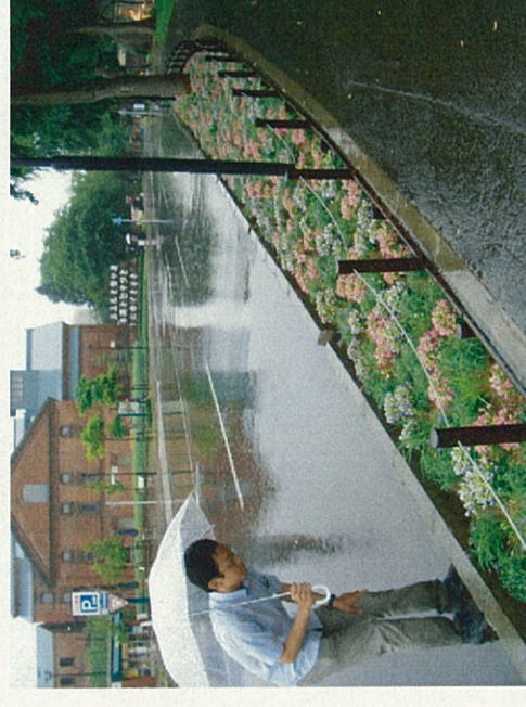
10 m/mの雨の中、雨水を吸収・浸透
