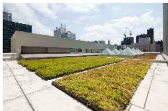
断熱性能に寄与する屋上緑化
