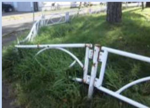
【外柵フェンス（老朽化・破損）】
