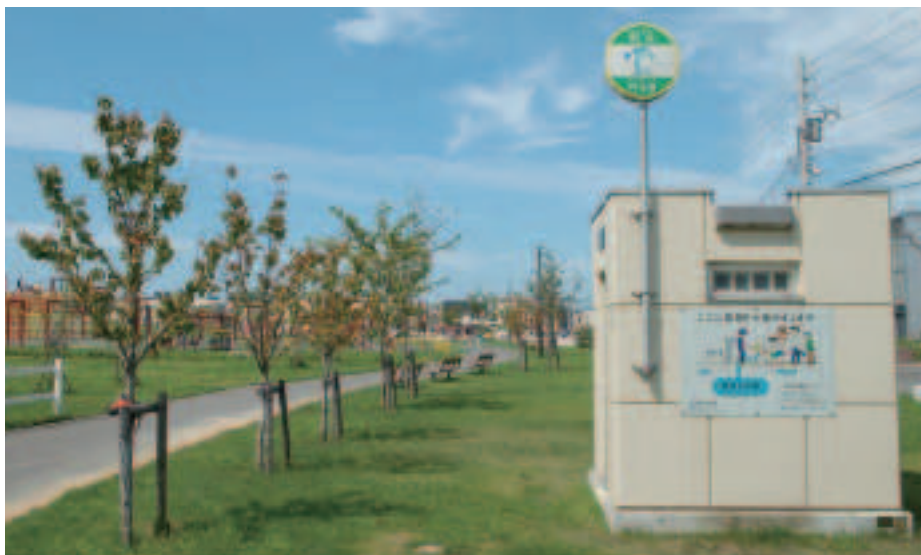
緊急貯水槽を設置した公園[明日風公園]
