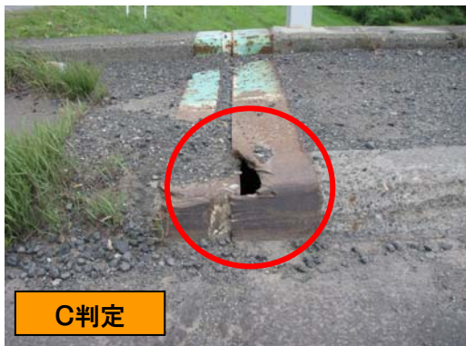
【伸縮装置】欠損：C判定
