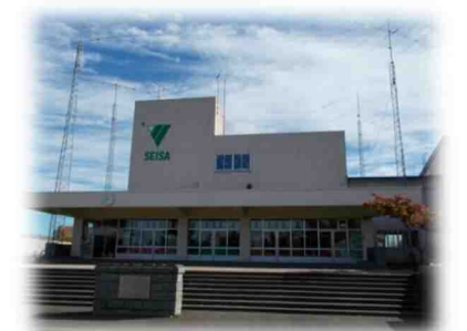
星槎国際高等学校・中学校 (旧もみじ台小学校)
