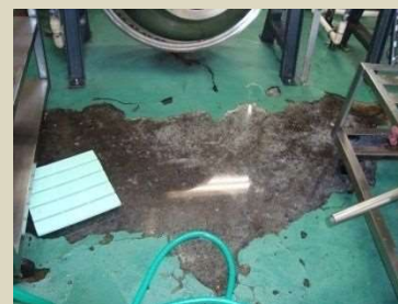
築34年 塗床の剥離
