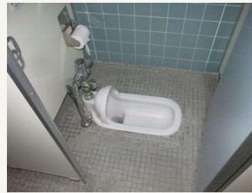
床がタイル敷きの和式便器
