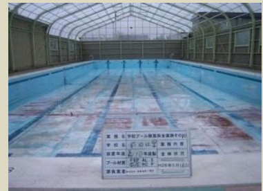
築16年 プール槽の塗装の劣化
