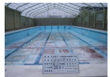
築16年 プール槽の塗装の劣化
