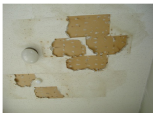
築 41 年 漏水による天井材劣化
