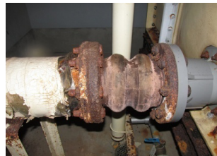
築 32 年 給水設備の老朽化
