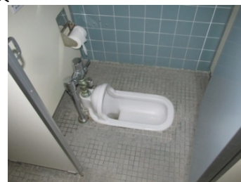
床がタイル敷きの和式便器
