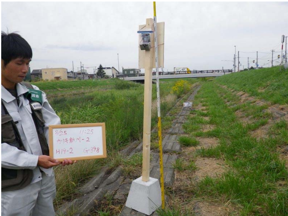
写真 2-3-2 雁来新川における自動撮影装置 (FC) の河川敷への仮設状況
