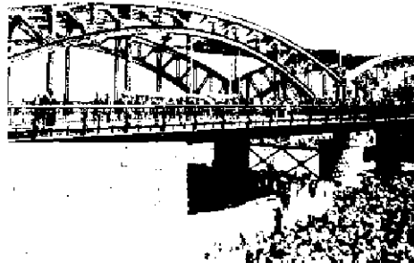
● 1924年（大正13）に竣工した豊平橋 （2点とも札幌市文化資料室所蔵）
