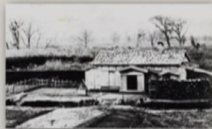
図中の「宗廟御林様」の家、家の前に防火用の水桶が見え、その脇に下水を流った跡らしい跡が見えます。建物前の溝が後の創成川です。
