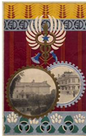
資料24 写真左は豊平館。写真右は札幌区役所。
