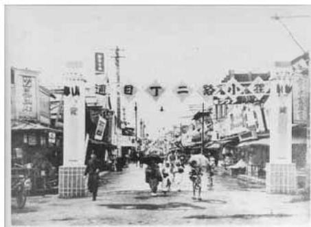
19 狸小路の舗装道路
