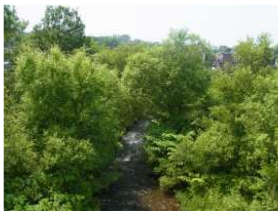
真栄橋より上流側
