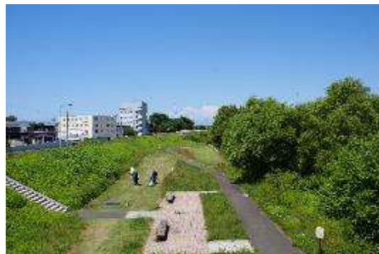
実橋から下流側左岸
