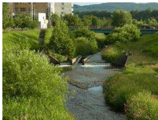
厚別橋より上流側
