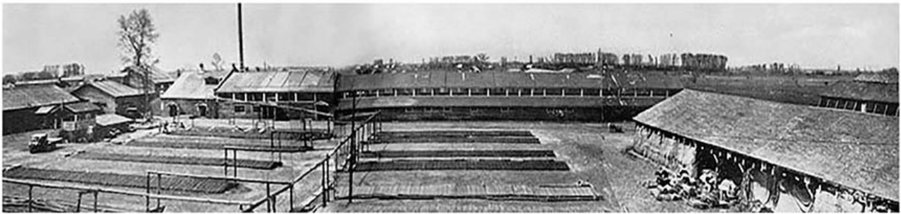
▲工場 ちゅうしんぶ の中心部 ようす の様子
