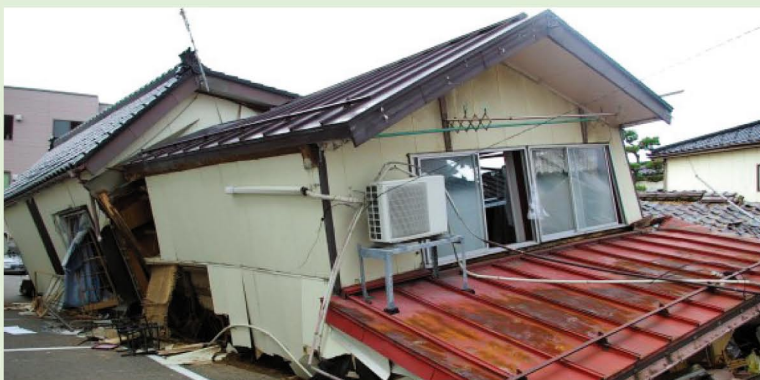
2007年新潟県中越沖地震 写真提供:首都大学東京 都市環境学部
