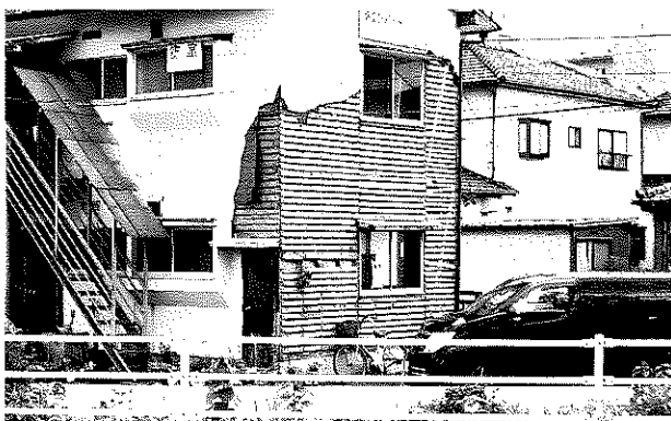
り災したアパート
