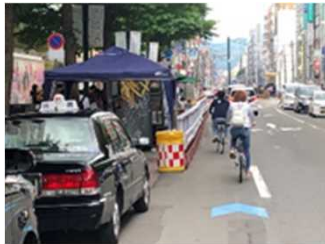
矢羽根型路面表示の整備
